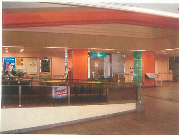
〈改修前〉暗い玄関ホール
