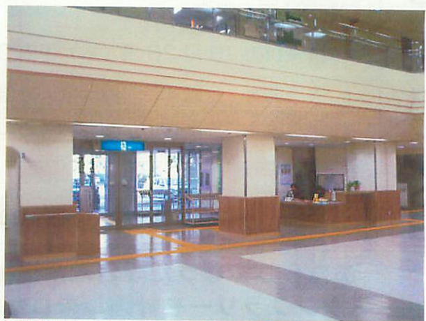
→ 〈改修後〉柱・壁の腰部分に県産材を使用、明るい玄関ホール
